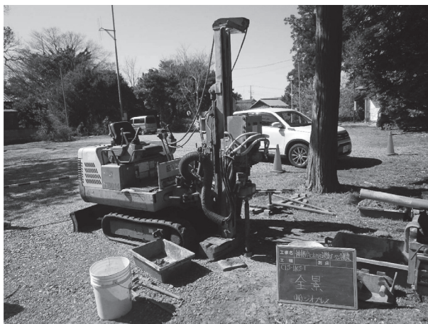
図2 息栖神社におけるボーリング掘削の様子
