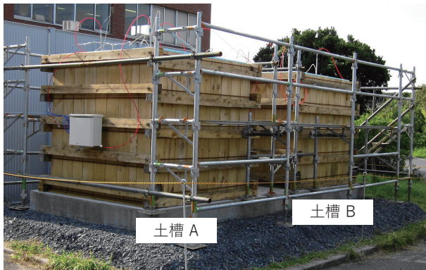
図1 屋外模擬土槽完成時の外観
