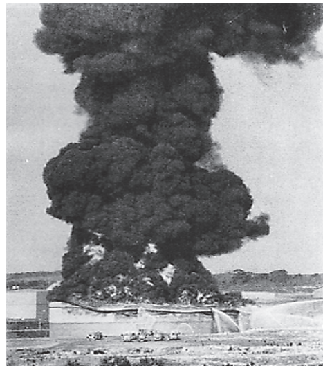
図1. 出火から4時間15分後、座屈が始まっている
