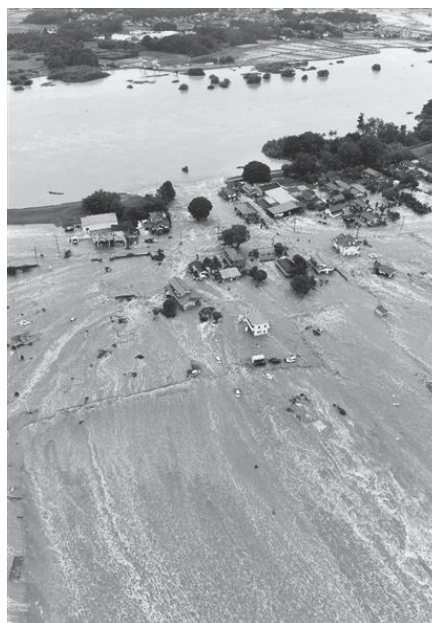
写真-5 堤防決壊箇所付近（サンケイニュースより）
